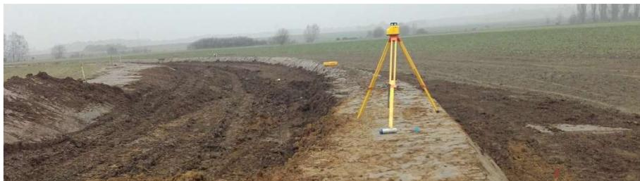
*Photo 17 : exemple d'un merlon de ceinturage associé à une noue*
