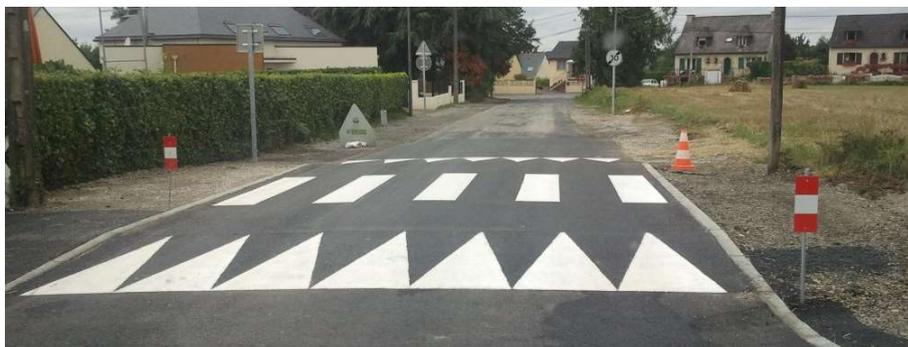
*Photo 19 : exemple de ralentisseur permettant de rediriger les écoulements*
