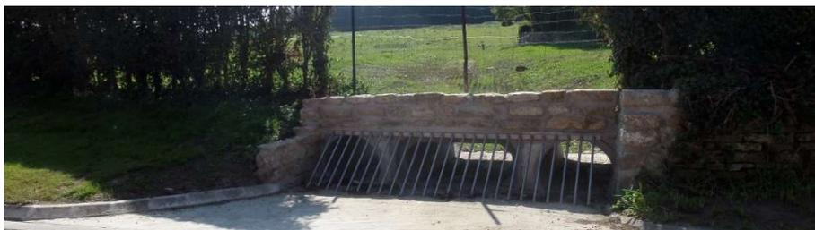
*Photo 18 : exemple de grille anti-embâcle en limite de propriété*
