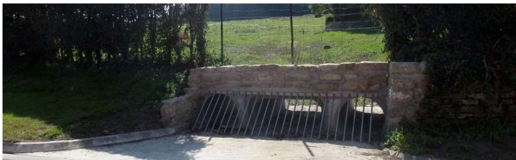
Photo 31 : exemple d'aménagement d'un dalot avec grille de protection
