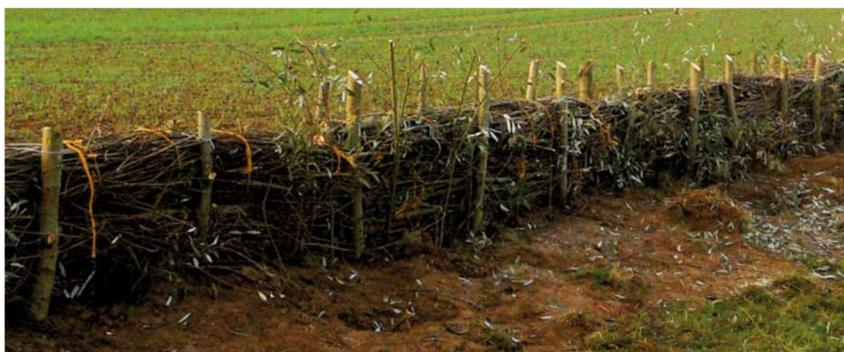
Photo 21 : exemple du modèle de fascine retenue
